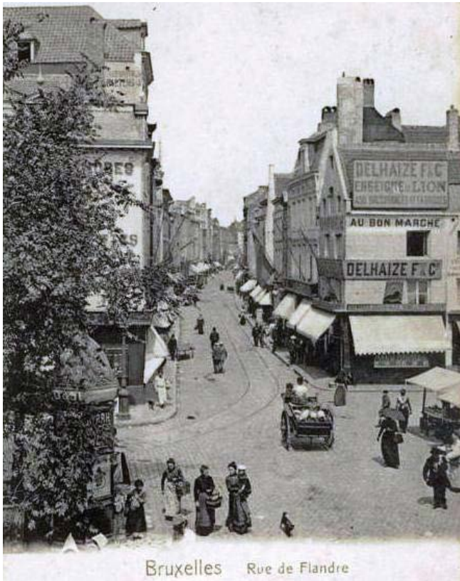
Zicht op de Vlaamse Steenweg uit de tijd dat Elsschot in Brussel woonde.
