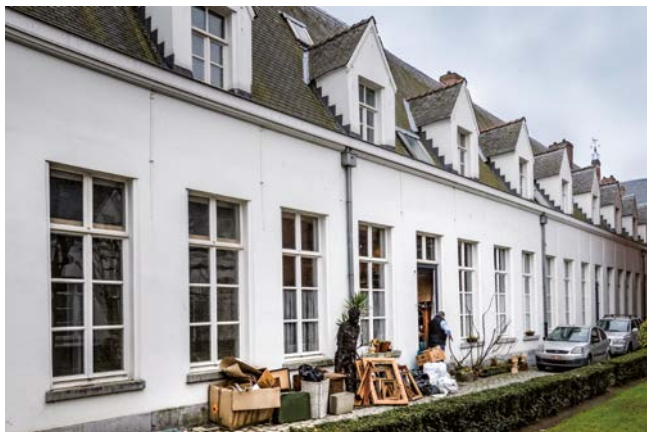
Het aan de buitenkant reeds gerestaureerde atelier van Willem Dolphyn.
